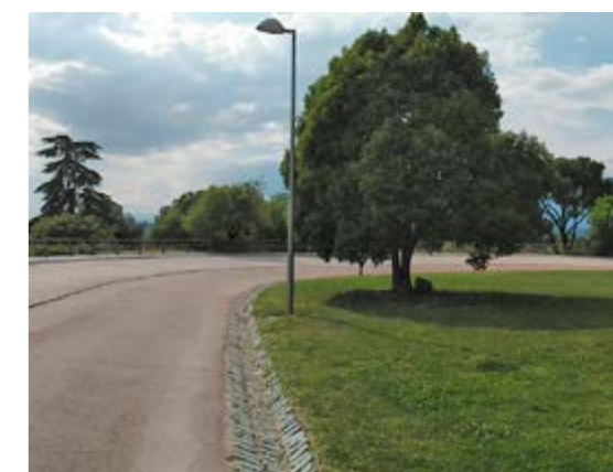
Imagen 8.3 Caceras de recogida de pluviales
