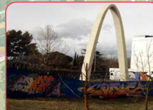
Imagen 6.5 Subestación Transformadora Ciudad Universitaria
