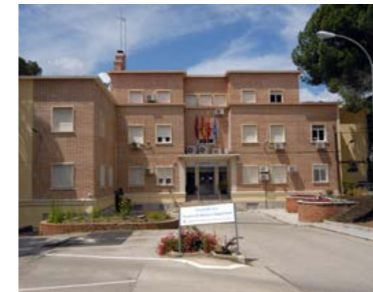
Imagen 10.1 Edificio Centro de Prevención de Riesgos Laborales Fabiola de Mora y Aragón
