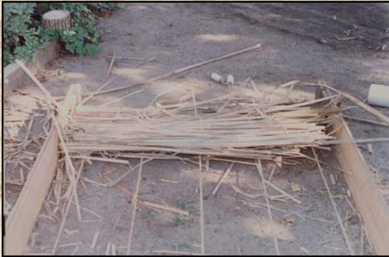
Para la confección del zarzo la espadaña se extendía en dos tandas opuestas sobre cuatro cuerdas tensadas, dentro de un bastidor de 1,30m. que daba forma al zarzo.
