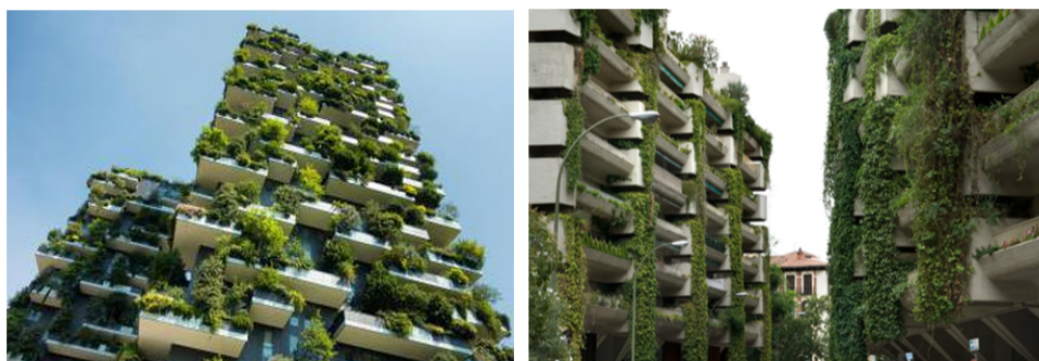
Figura 2.2: A la izquierda se muestra la imagen de una fachada verde modular con vegetación en las terrazas y a la derecha fachada verde modular con vegetación en jardineras en Madrid
