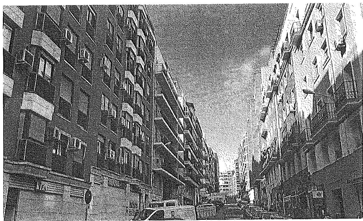
Edificios tipo en calle de Valderibas.
