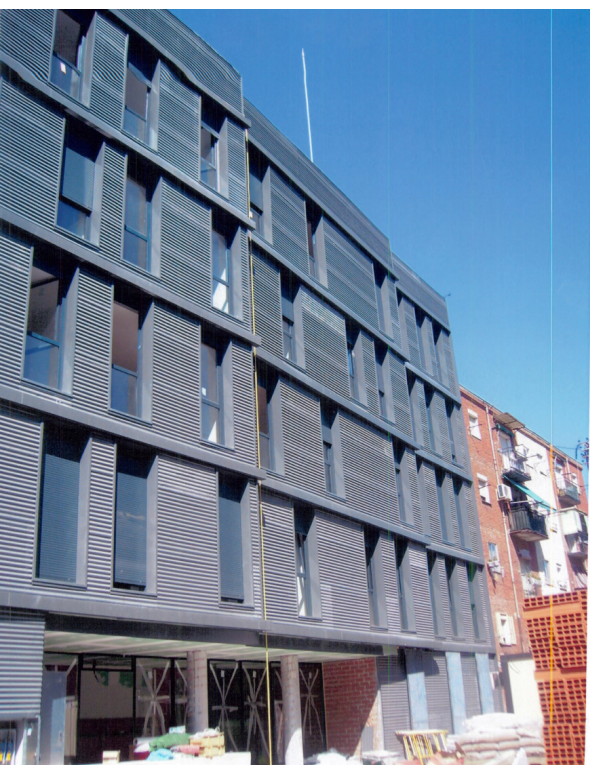
Estado de Obra a Fecha:
