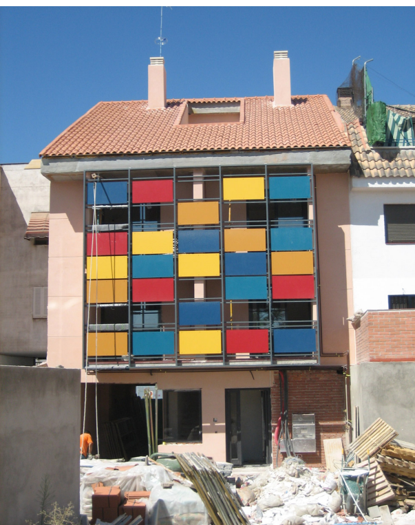
Estado de Obra a Fecha: 01/04/2008
