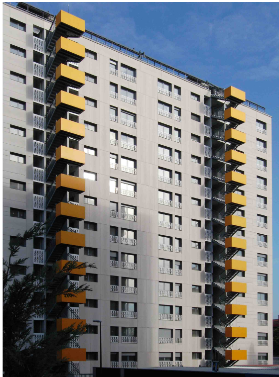
Estado de Obra a Fecha:
