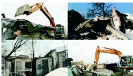
Derribo de chabolas
