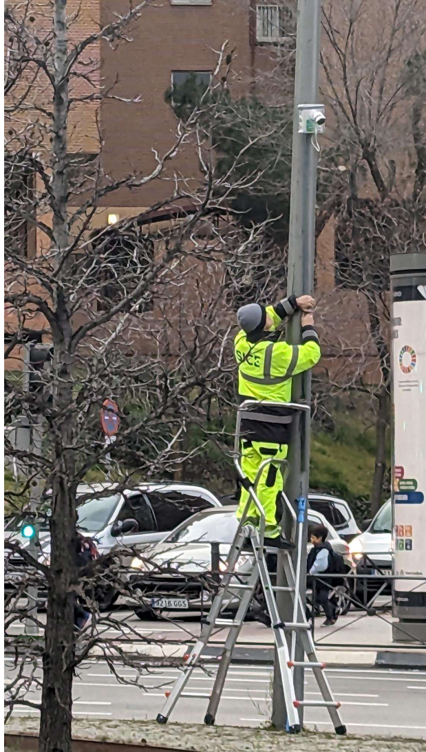
Aforador por cámara temporal de grabación de video.
