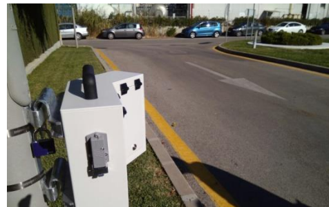
Ilustración 1 Aforador por tecnología Radar "Efecto Doppler"
