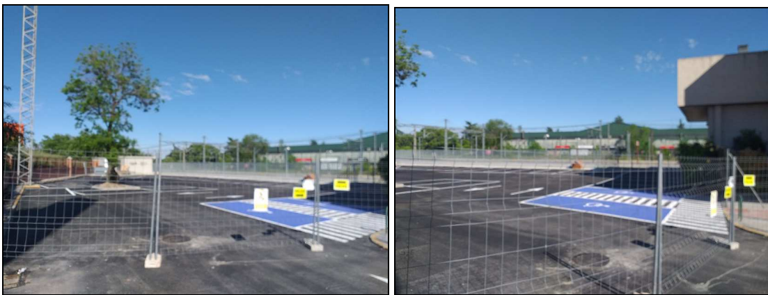
Fotos 5 y 6.- Aparcamiento público vinculado a Cercanías. En obras (30 plazas aproximadamente).
