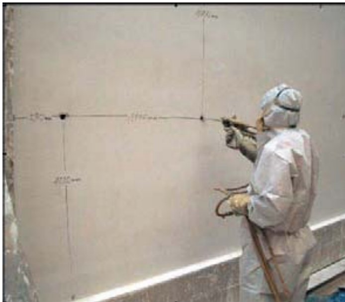
Ejemplo de la ejecución de una rehabilitación de fachadas con aislamiento térmico por inyección en cámaras.
