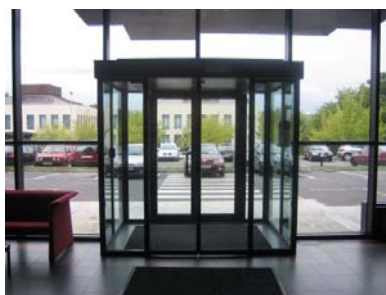
Sistema de doble puerta en acceso de edificio
