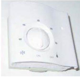
Termostato de una instalación de climatización
