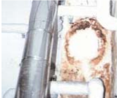
Sustitución de chimenea de acero inoxidable
