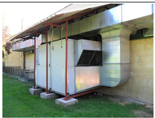
Climatizadora-Deshumectadora. Piscina
