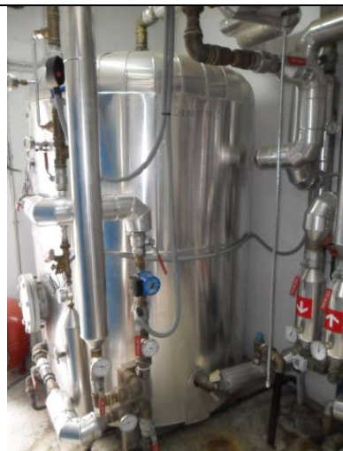
Acumulador Solar (Depósito 1) – Campo de Fútbol
