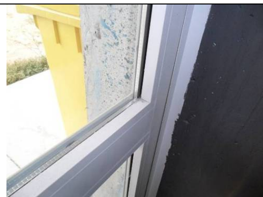
Detalle Ventana. Oficinas
