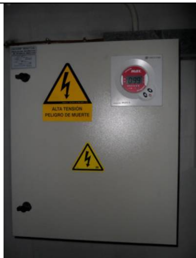
Batería de condensadores
