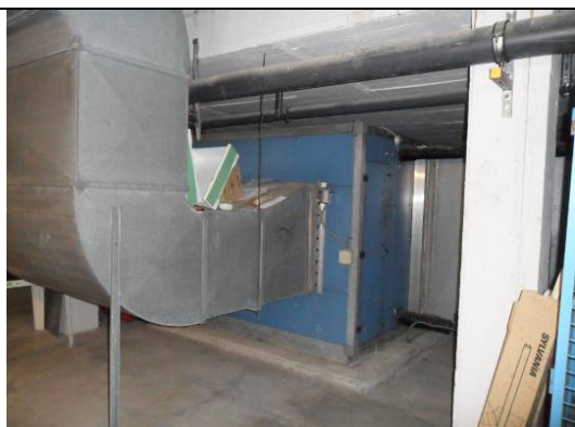
Climatizadora. Piscina Cubierta
