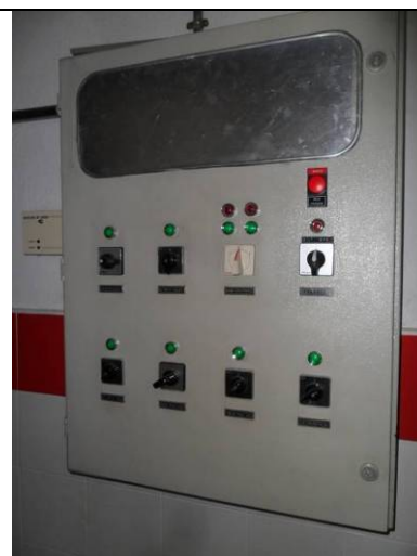
Cuadro Sala Calderas. Vestuarios Personal y Oficinas
