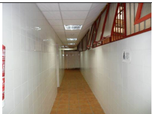
Carpintería exterior pasillos
