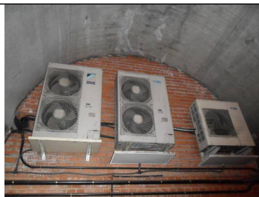
VRV y equipo autónomo
