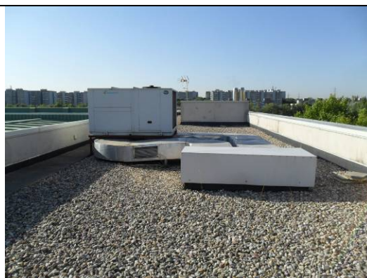
Bomba de Calor Sala de Musculación
