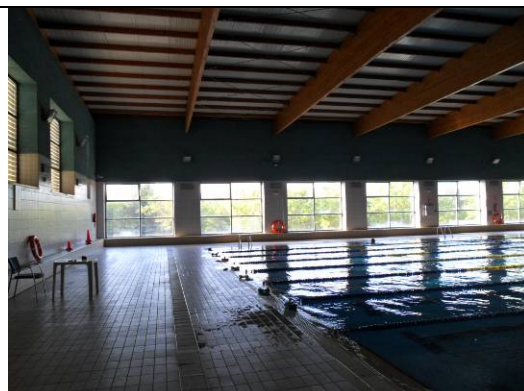
Carpintería exterior Piscina
