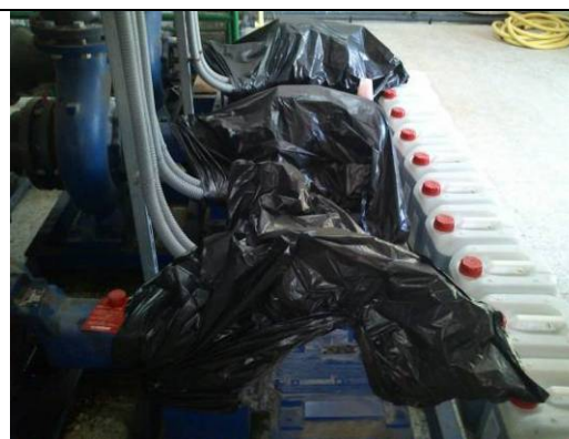
Depuración piscina verano
