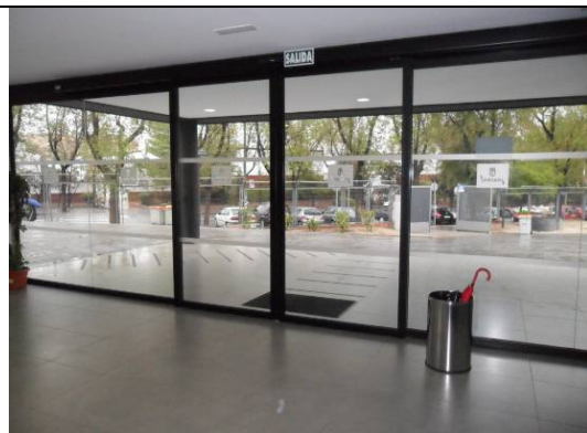
Hall Entrada. Pabellón
