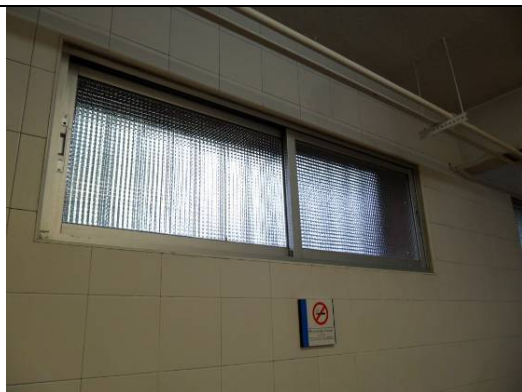
Ventana. Vestuarios Campo Futbol
