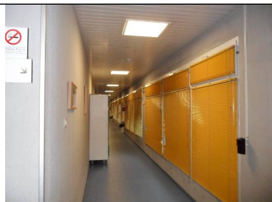
Pasillos de Piscina Cubierta
