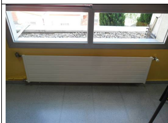
Radiador. Oficinas 1ª planta
