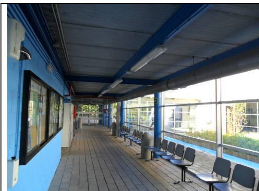
Carpintería exterior Piscina
