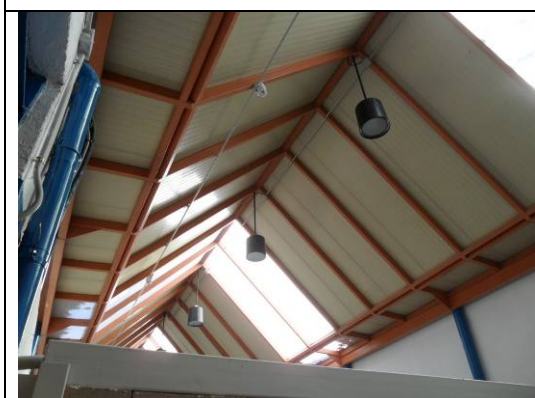
Iluminación Piscina de verano
