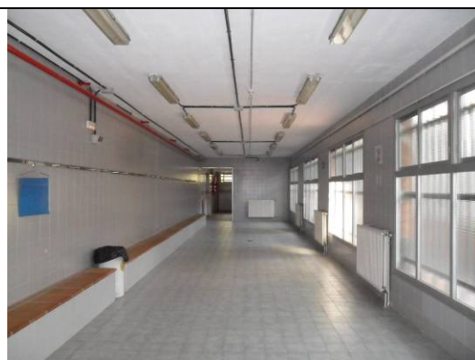
Carpintería exterior vestuarios Piscina de verano
