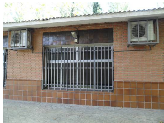
Carpintería exterior aulas
