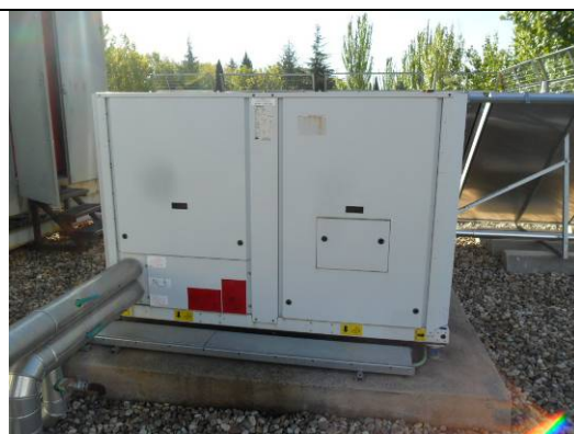
Enfriadora Aeróbic y Sala de Musculación
