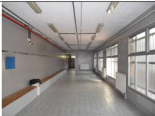
Climatizadora Piscina de verano
