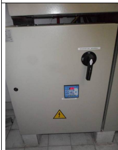
Batería condensadores
