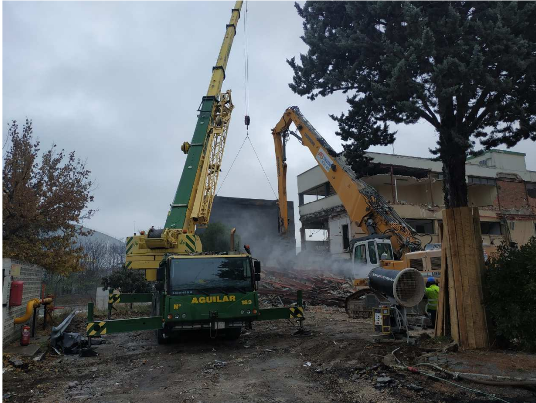
Imagen 1 humedecimiento con cañón de agua y apantallamiento de emisiones con lona.
