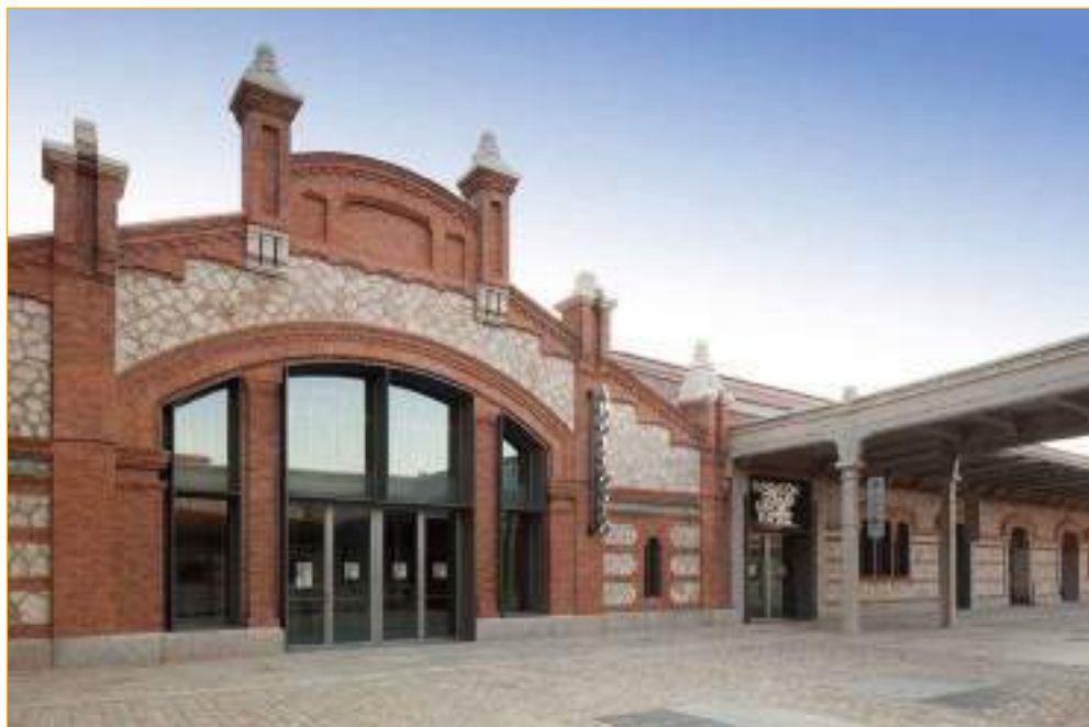
Naves de Matadero Madrid Centro de Creación Contemporánea
