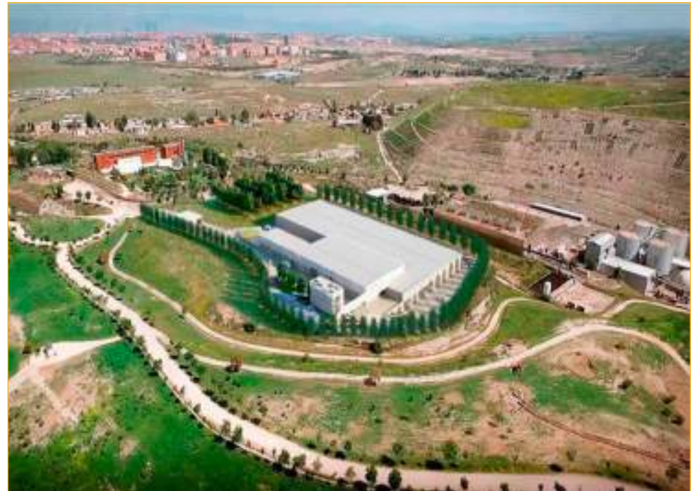
Planta de Tratamiento de materia orgánica de Valdemingómez
