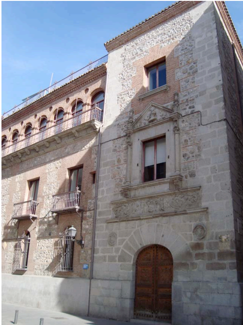
Fig. 20: Casa de Cisneros. Fachada hacia la calle del Sacramento
