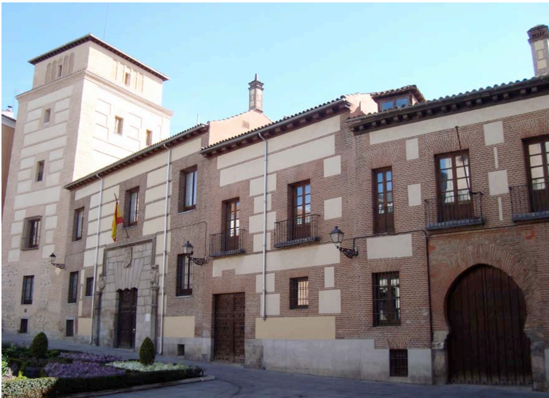
Fig. 15: Casa y Torre de los Lujanes
