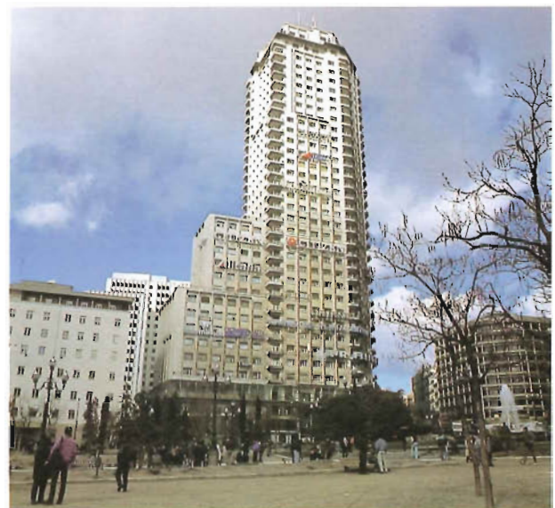
Torre de Madrid.
