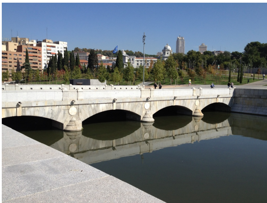
El Puente del Rey con la Puerta de San Vicente y la Estación de Príncipe Pío al fondo.
