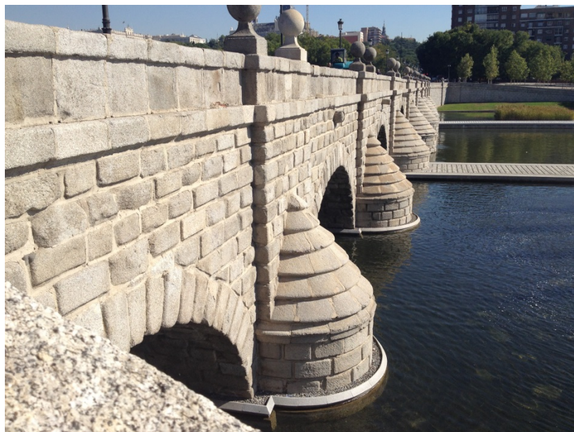
Detalle de los tajamares semicirculares del Puente de Segovia.
