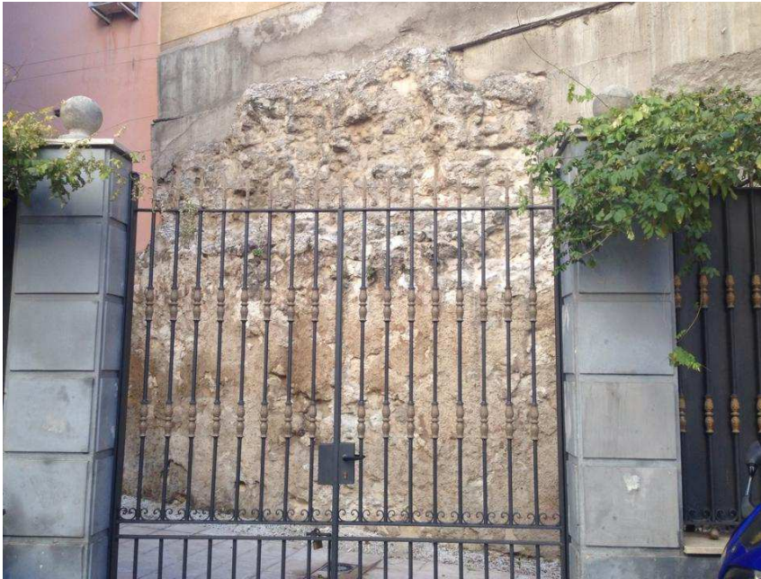
Restos de la Muralla Cristiana, Calle de Los Mancebos.
