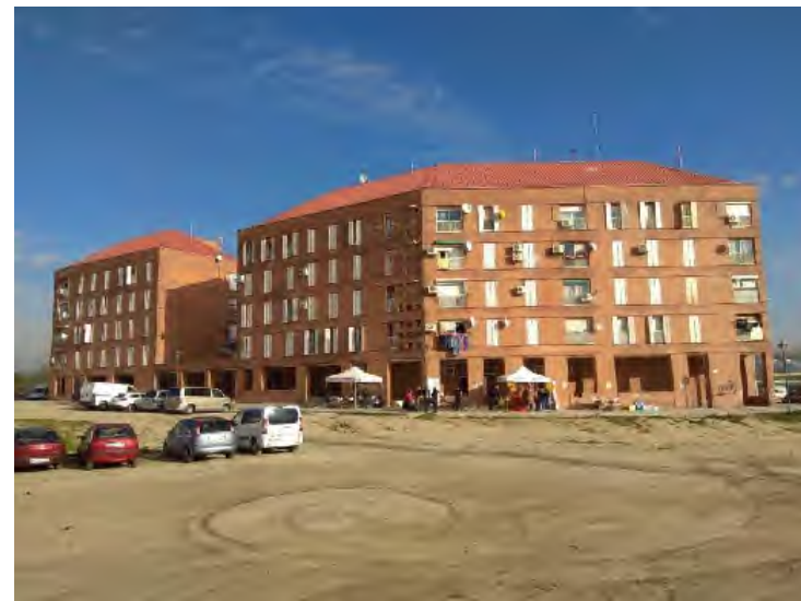
Foto 6. Acceso a las viviendas de Plata y Castañar por la calle Villalonso.
