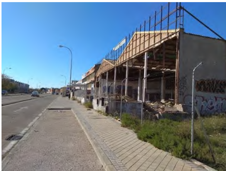
Foto 16. Nave desmantelada en Calle Real de Pinto. Área industrial de Villaverde.
