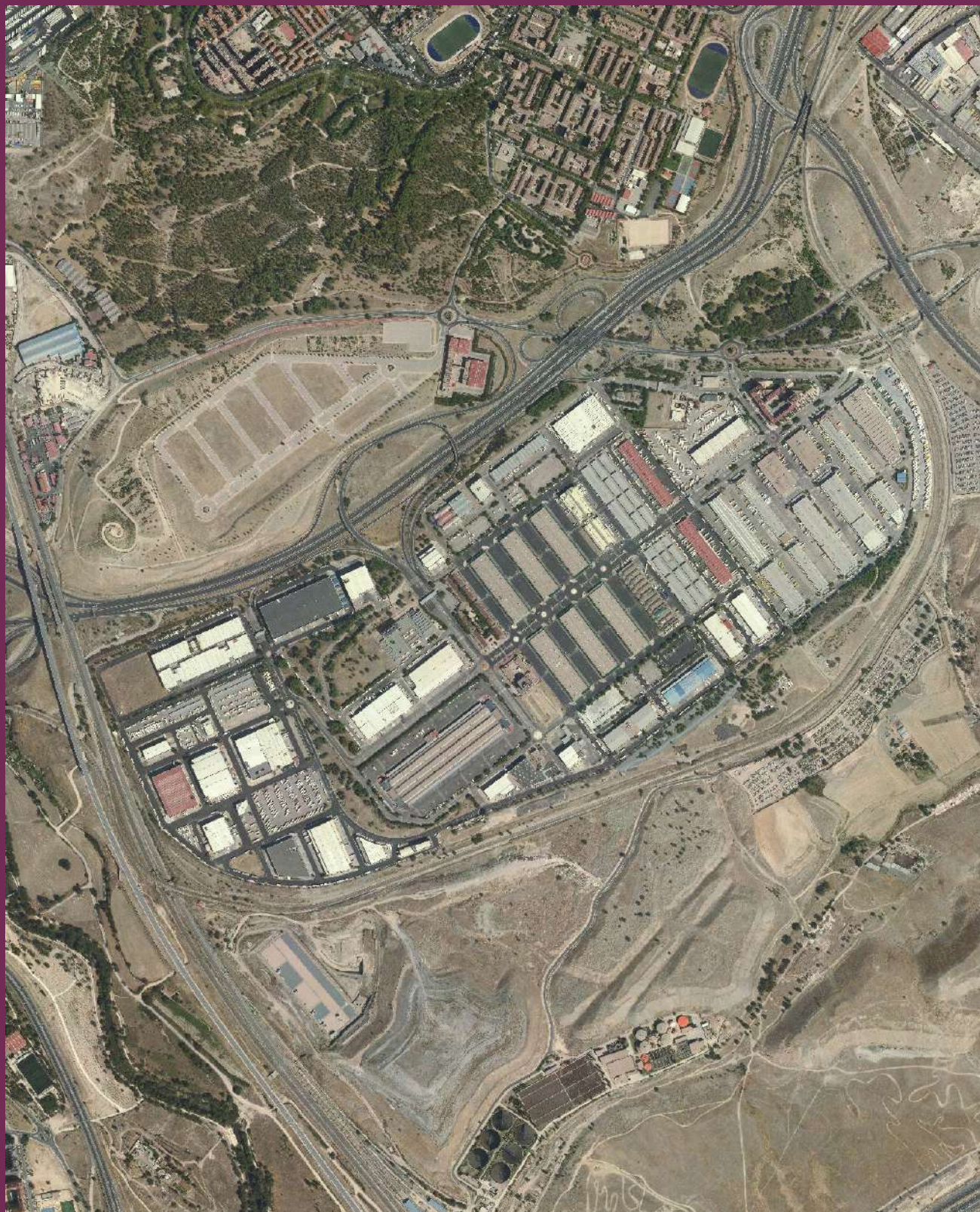
Instalaciones de Mercamadrid y del Centro de Transportes de Madrid
