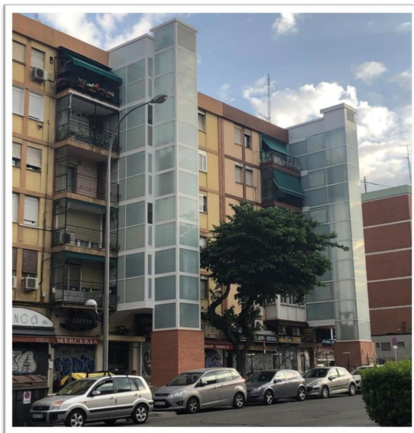
Imagen instalación finalizada de torre de ascensor en fachada
