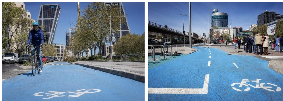
Vista actual del carril bici de Castellana
